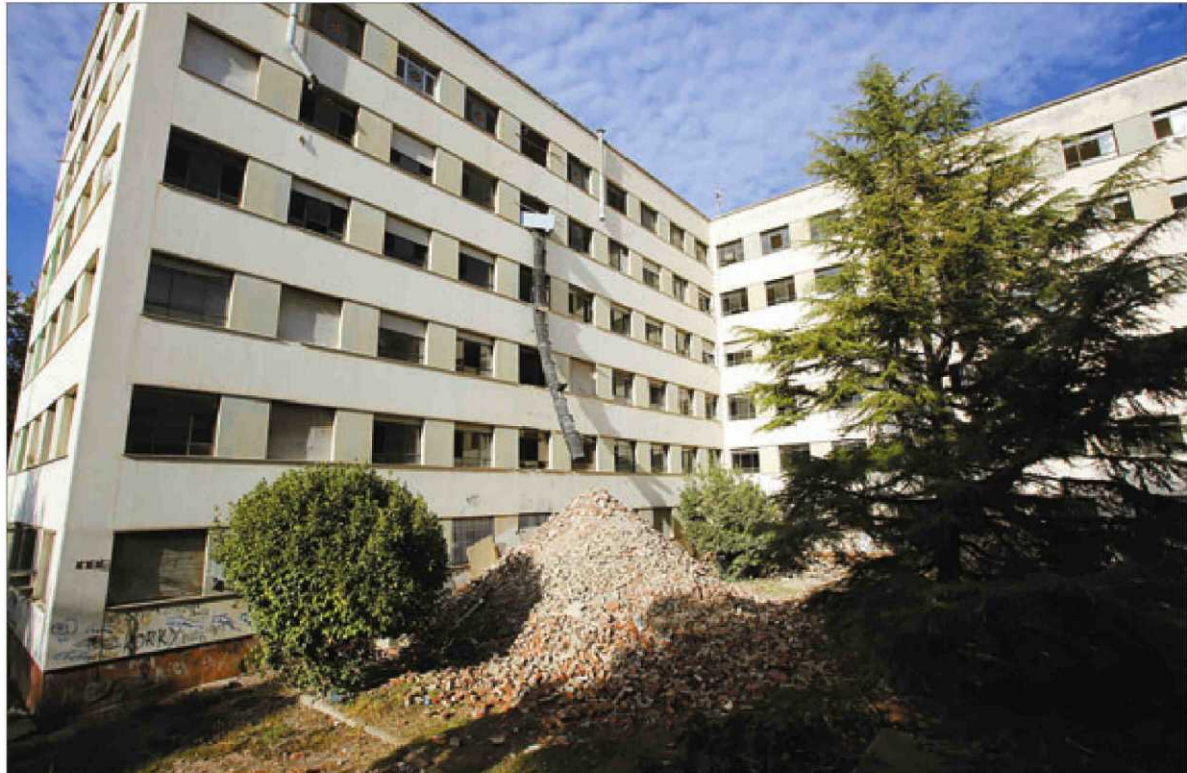
La obra para reorganizar las sedes de Industriales ha comenzado con el vaciado del ala norte de la antigua Facultad de Ciencias. / FOTOS: JONATHAN TAJES
